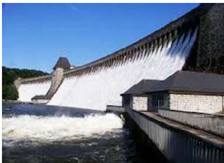
Le barrage de Möhnesee près de Ense.
